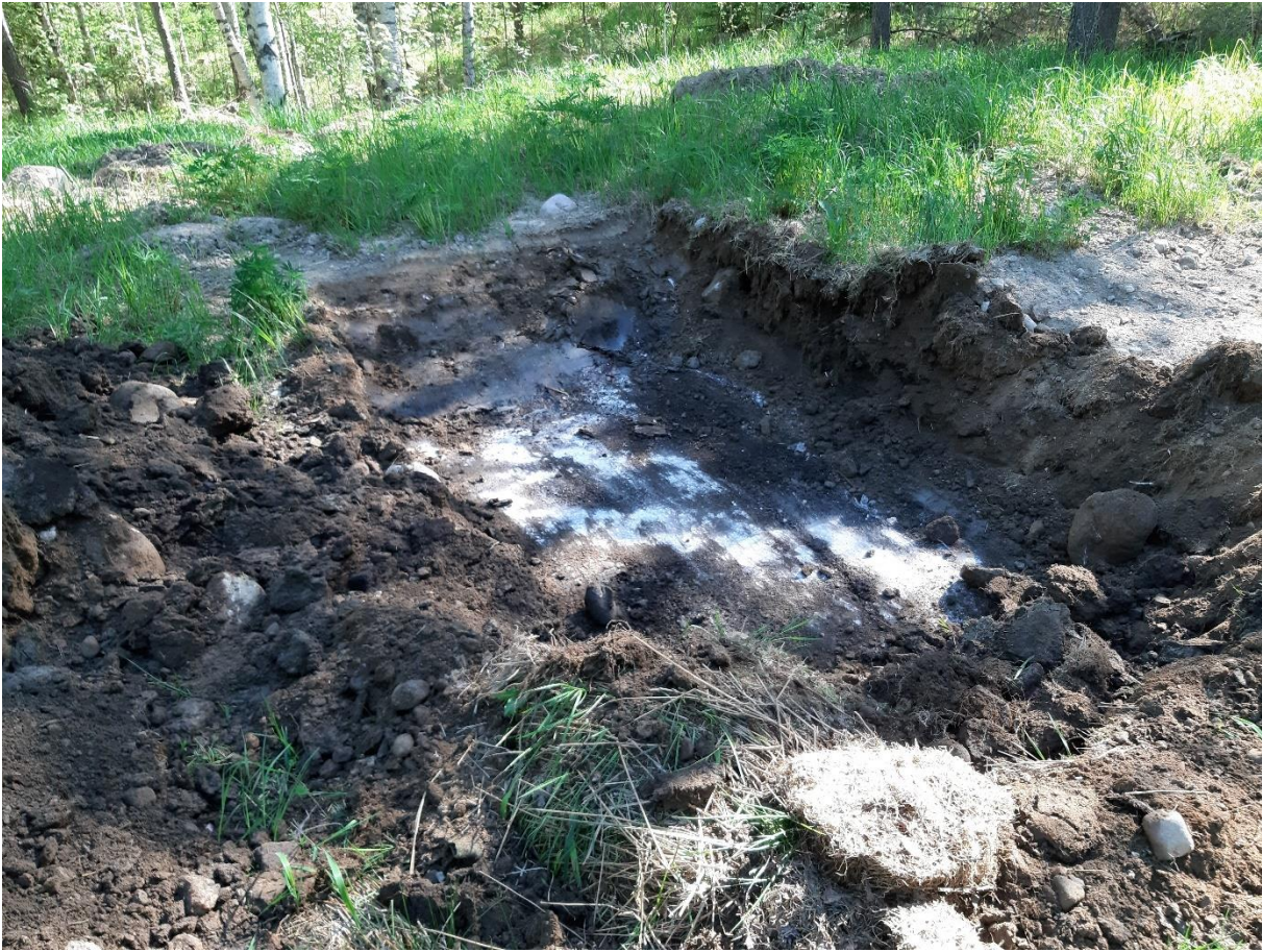
Kuva 23. Koekuoppa SW19. Kohdassa todettiin kallion pinta.
