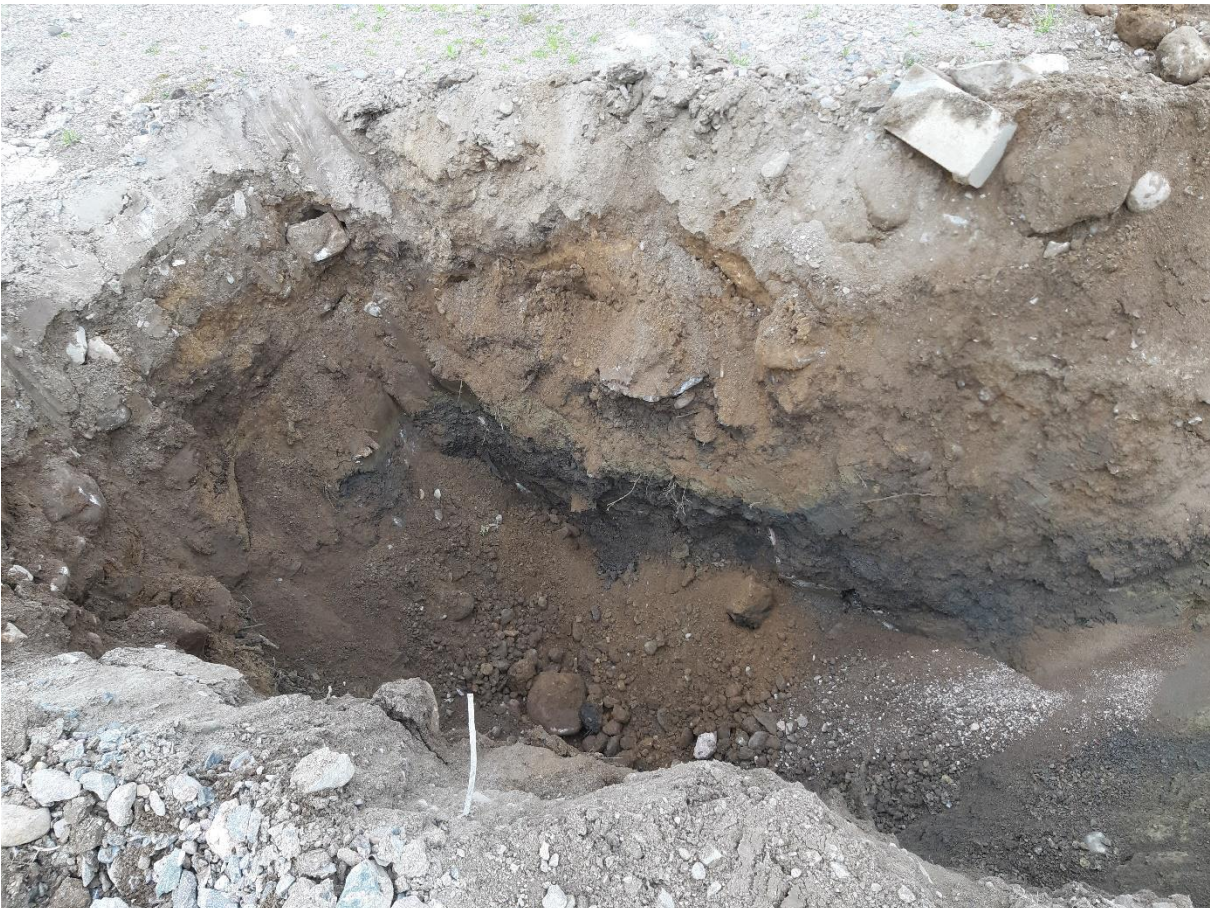
Kuva 6. Koekuoppa SW4. Maakerroksissa todettiin kynnyksarvot ylittäviä haitta-ainepitoisuuksia.
